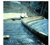
Ejemplo de talud reforzado con suelo reforzado.
